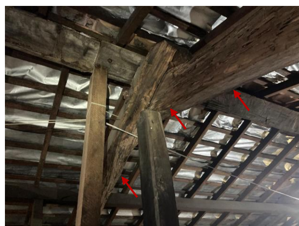
Figura 37 – Detalhe das tesouras degradadas, com perda considerável da seção resistente
