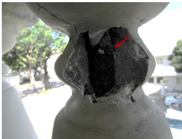
Figura 41 – Detalhe do ferro da balaustrada com corrosão e consequente deslocamento do substrato
