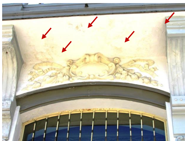
Figura 30 – Detalhe das manchas de umidade sob a laje da sacada central na fachada leste
