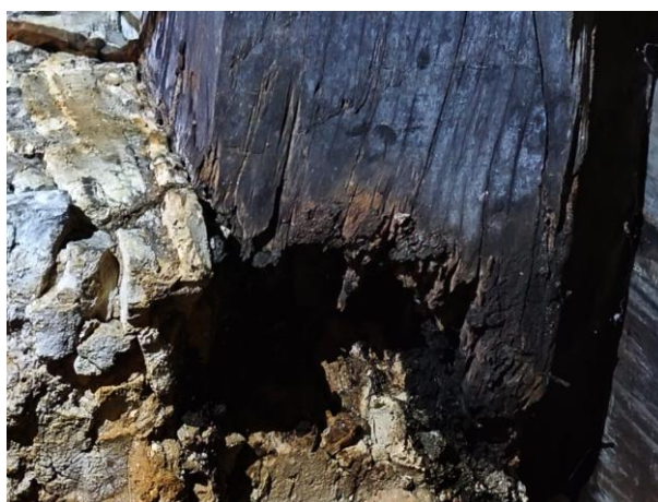
Figura 63 - Dano severo por umidade e apodrecimento na cabeceira de viga de madeira do piso superior
