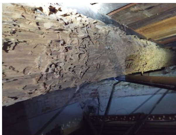
Figura 40 - Detalhe da viga de madeira do piso do pavimento superior degradada, com perda considerável da seção resistente
