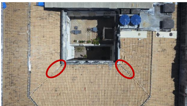
Figura 31 - Detalhe das cumieiras com parte das telhas ausentes
