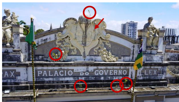
Figura 29 - Detalhe da platibanda e marquise com acúmulo de matéria orgânica (generalizado) e crescimento de vegetação (círculos) e apontamento para produto de corrosão no Brasão
