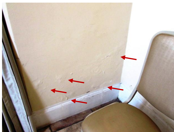
Figura 44 -Detalhe da parede com umidade e desprendimento do substrato e pintura (sala de espera)
