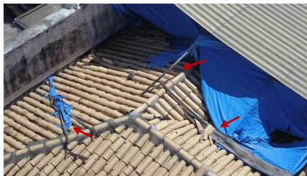
Figura 35 – Detalhe da estrutura auxiliar da cobertura temporária danificada
