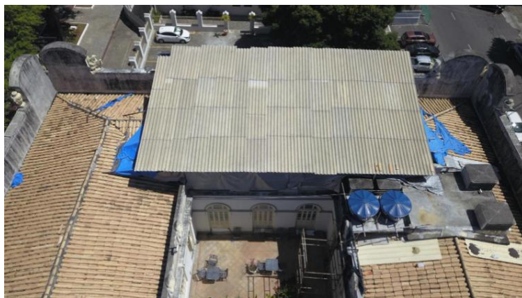
Figura 9 – Cobertura provisória instalada sobre o salão de jantar
