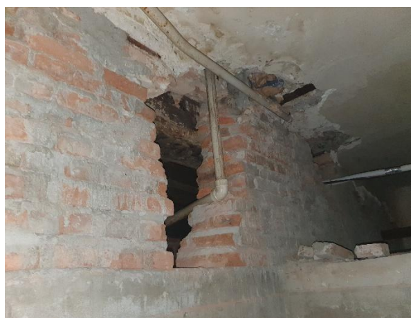
Figura 12 – Detalhe do entreforro da sala de segurança, com alvenaria em tijolo maciço e viga de concreto
