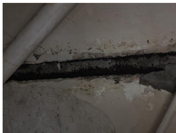
Figura 16 - Detalhe da barra chata de ferro na laje do banheiro da suíte do Governador
