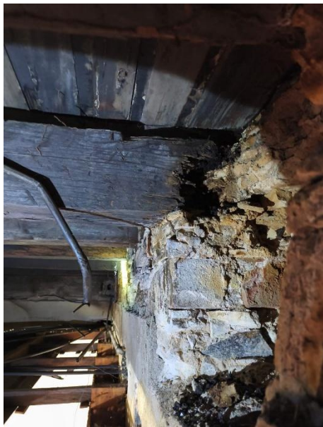
Figura 38 - Detalhe do entreforço da sala cidade de Aracaju, com madeira da estrutura do piso do salão de jantar apresentando dano severo na cabeceira
