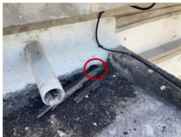
Figura 34 - Detalhe do dreno com a seção significativamente bloqueada por sujeiras e ausência de declividade para escoamento
