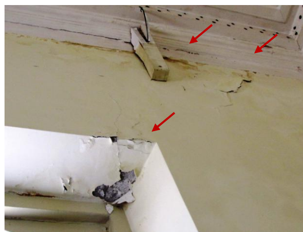
Figura 43 – Detalhe da parede com umidade, acúmulo de matéria orgânica e desprendimento do substrato e pintura (WC da suíte do governador)
