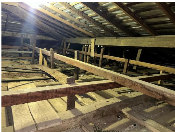
Figura 21 – Detalhe da estrutura de suporte do forro, composta por um conjunto de barrotes
