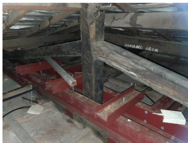
Figura 26 – Detalhe dos perfis metálicos instalados na cobertura, sobre a sala de reunião
