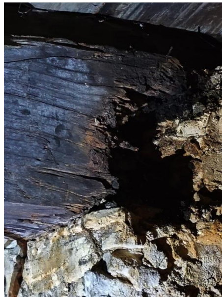
Figura 39 - Detalhe da madeira da estrutura do piso do salão de jantar com dano severo na cabeceira e presença de umidade
