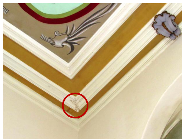
Figura 49 – Detalhe da mancha de umidade no forro com pintura artística (galeria de artes)
