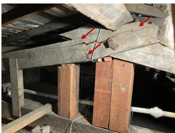
Figura 36 – Detalhe da tesoura rompida, apesar do gancho de reforço
