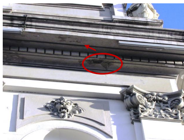
Figura 28 - Detalhe da moldura da marquise com perda do substrato (círculo) e zona de acúmulo de umidade (seta)
