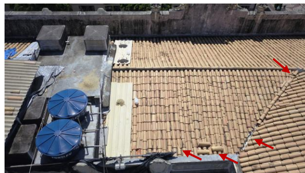
Figura 32 - Detalhe do telhado com telhas deslocadas, faltantes e danificadas
