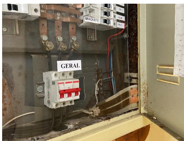
Figura 53 – Detalhe QD2 – circulação 2 com barramentos e conexões oxidadas e corrosão no quadro
