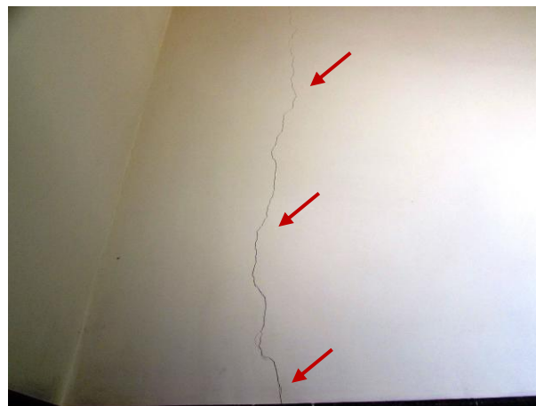
Figura 47 - Detalhe da trinca vertical na parede leste do banheiro da suíte do governador, que se estende até o topo
