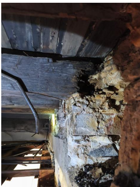
Figura 11 – Detalhe do entreforro da sala cidade de Aracaju, com pedra calcária assentadas com argamassa de cal e viga de madeira
