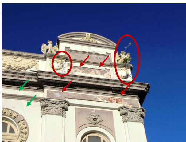
Figura 27 - Detalhe da platibanda e marquise com acúmulo de matéria orgânica (generalizado), crescimento de vegetação (círculos), desagregação do substrato (seta vermelha) e trinca (seta verde) na parte adjacente
