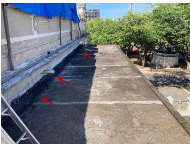
Figura 33 - Vista da laje do terraço coberto com impermeabilização ausente, acúmulo de sujeiras próximo aos drenos (setas) e declividade deficiente
